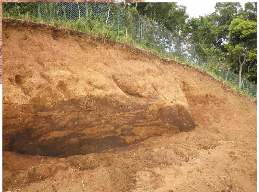
2012年時の掘削状況
