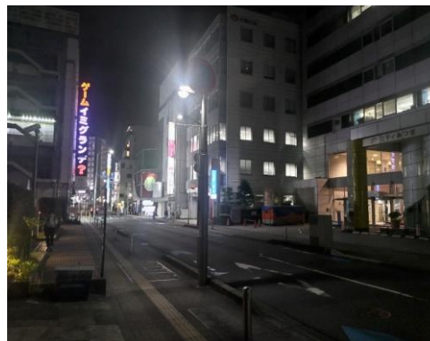
修繕後の写真 電球の交換(正常に点灯)
