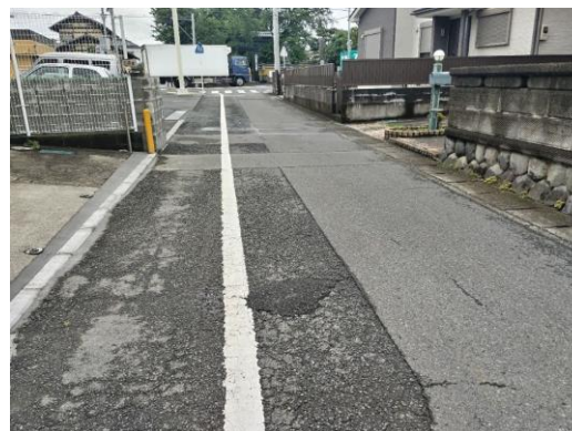
修繕後の写真 道路(穴埋め/常温合材による修復)
