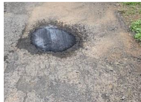
修繕後の写真 道路(穴ぼこ／常温合材による修復)
