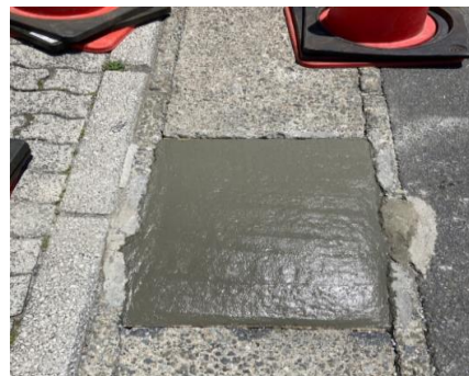
修繕後の写真 道路(甲蓋の補修)
