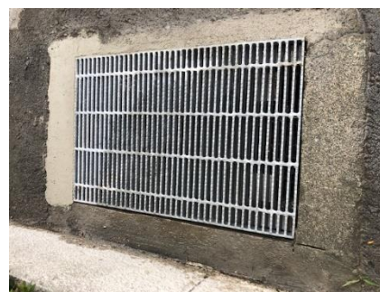
修繕後の写真 道路(グレーチングの交換)
