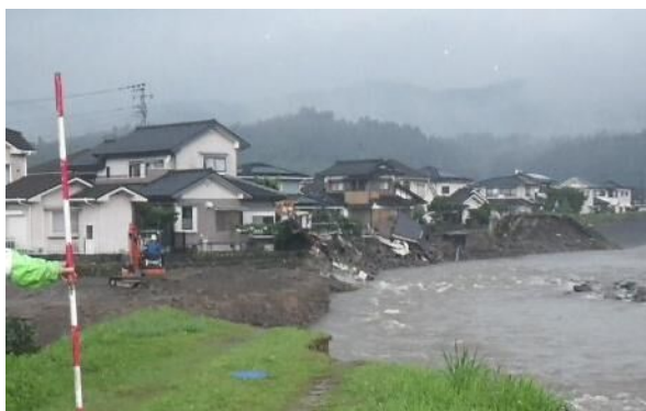
河岸侵食による家屋の倒壊(花月川)
