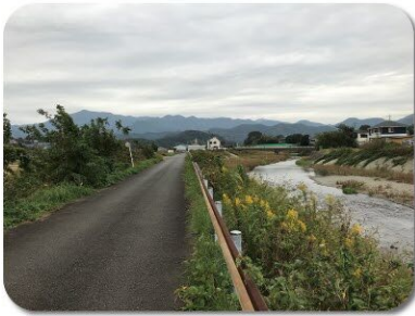
5 川沿いの道(千頭橋付近)
