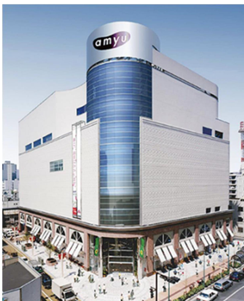
正面玄関側から撮影したアミューあつぎ
