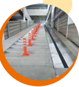
自転車を上階へ運ぶコンベアを備えたオートスロープ
