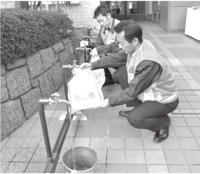
災害時には飲料水や生活用水として活用される井戸水
