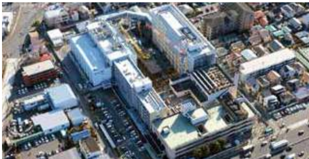
着々と建設が進む市立病院
