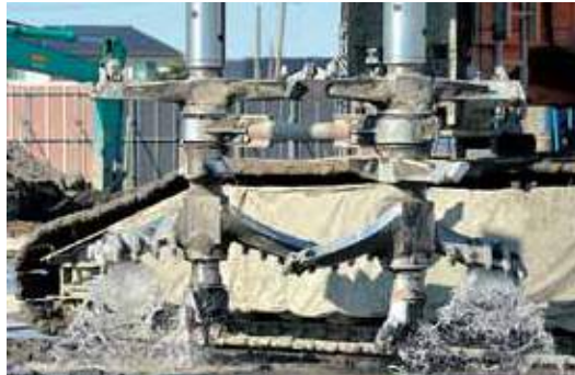
地中でくいの原料を混ぜ合わせる機械
