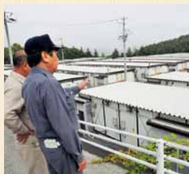
仮設住宅など、被災地の現状を確認した
