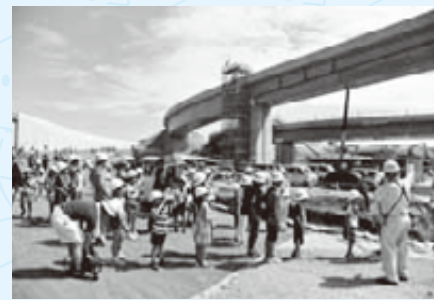
工事中の高速道路を間近で見学
