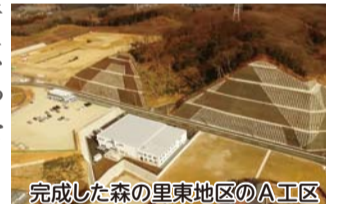
完成した森の里東地区のA工区
