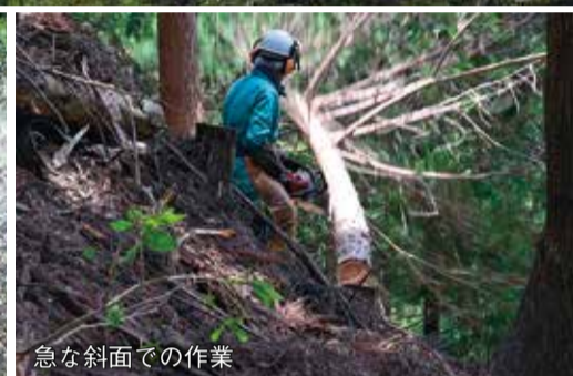
急な斜面での作業
