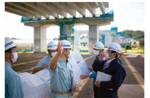
厚木土木事務所から県道整備の状況を確認
