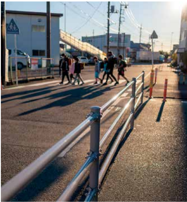
ウェアラブルカメラの映像を基に設置された防護柵（妻田小学校周辺）
