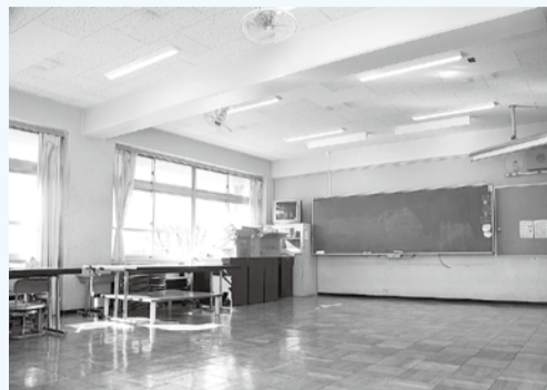
LED照明器具に交換した教室
