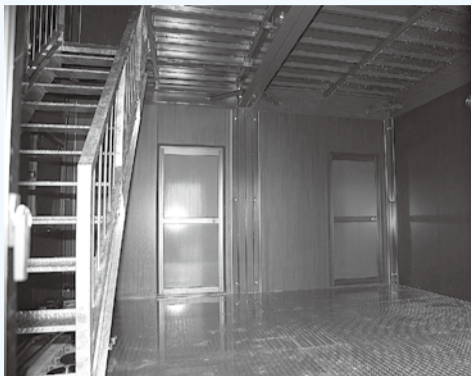
一般住宅を想定し、室内階段を設置
