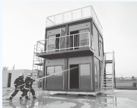
鉄骨造りの2階建て、総床面積は40.5平方メートル
