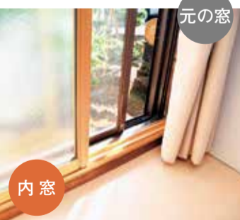
内窓設置で省エネに
