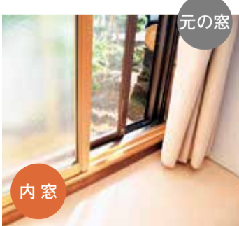
内窓設置で省エネに
