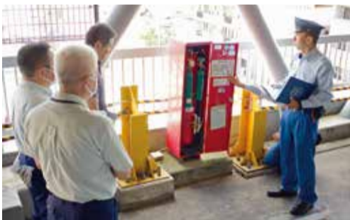
移動式粉末消火設備を検査する消防職員
