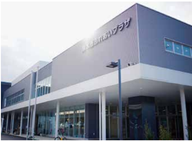
場所は金田1156番地。130台分の駐車場を設けた
