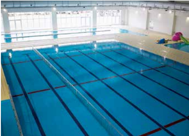
メインのプールは25m 8レーン（2レーンは歩行用）
