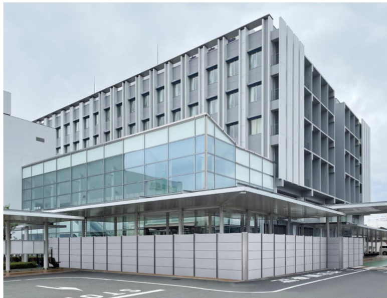
正面玄関 防水板設置イメージ写真
