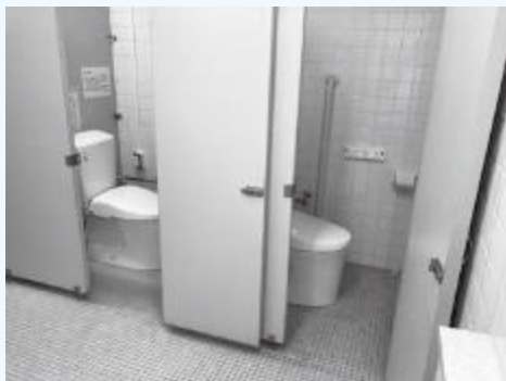
5基を改修した睦合北公民館
