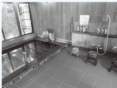
床材を耐水性のあるタイルに改修した浴場
