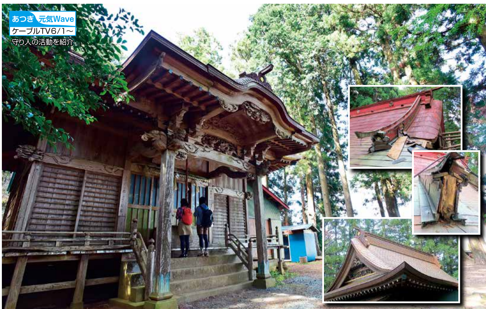
鐘ヶ嶽山頂付近で参拝者やハイカーを迎える浅間山七澤神社本殿。修繕前の屋根(右上・中央)と、修繕後の屋根(右下)
