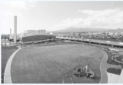
災害廃棄物を一時保管する緑地のエリア
