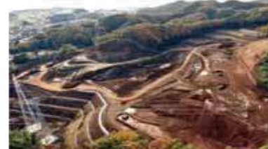
2023年度整備完了・企業立地予定のC工区
