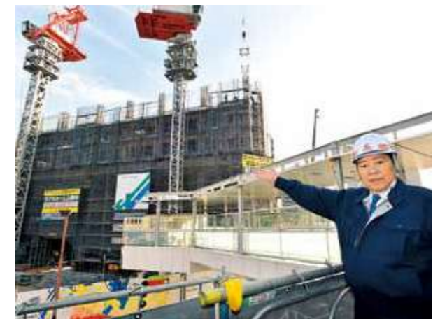
整備が進む本厚木駅南口
