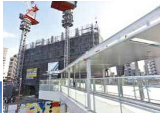
整備が進む本厚木駅南口
