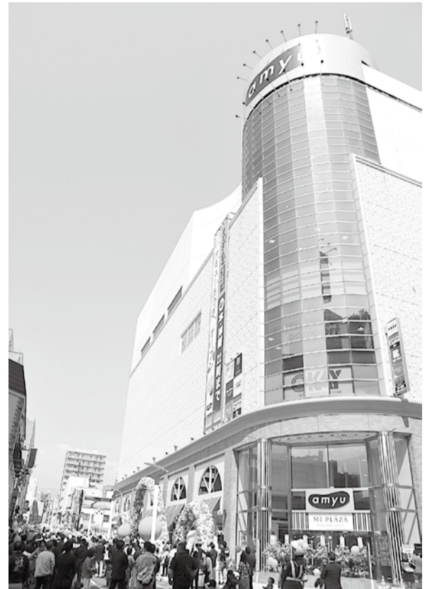
新たなにぎわいのシンボルになったアミューあつぎ。5階～8階は市の施設「あつぎ市民交流プラザ」
