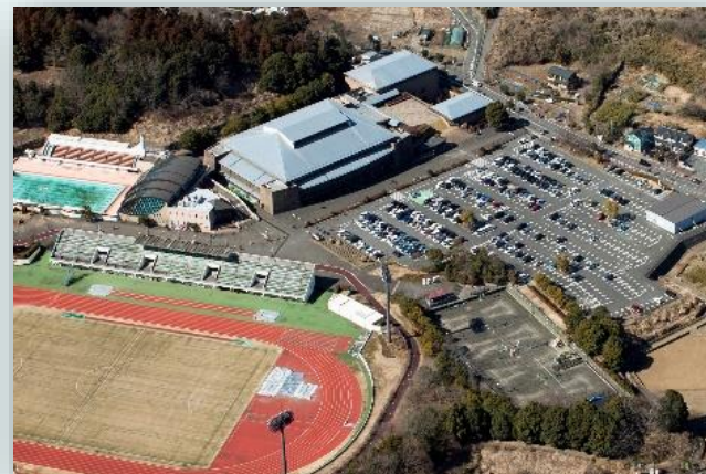
災害時の拠点である荻野運動公園に整備
