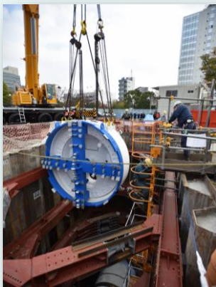
厚木排水区浸水対策北貯留管を掘削するシールド先端部
