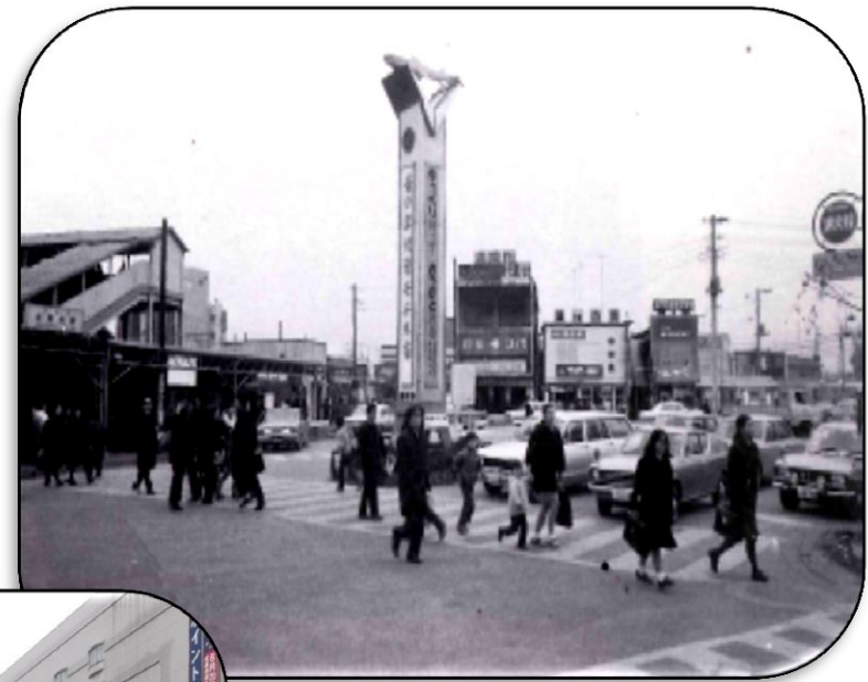
▲昭和50年頃の本厚木駅北口の街並み
