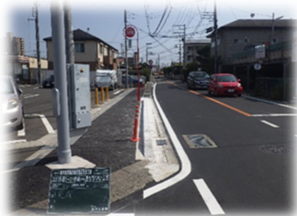
歩道拡幅改良工事
