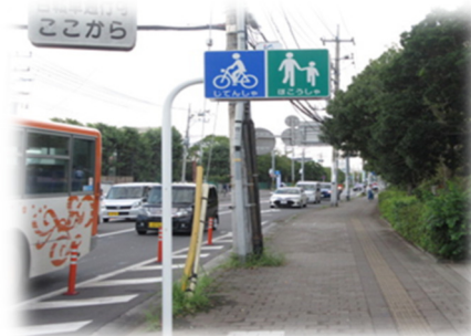
歩道上の自転車通行可標識整備
