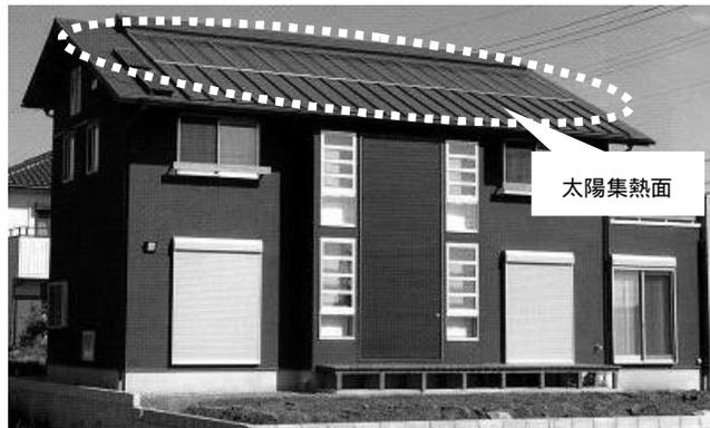
(写真) 住宅用太陽熱利用の事例 (出典: NEDO ソーラー建築デザインガイド)
