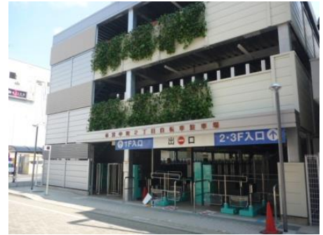
自転車専用駐車場
