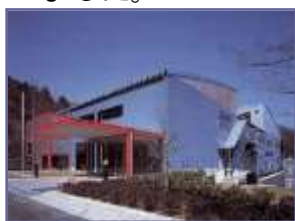
厚木市資源化センター (しげん再生館)
