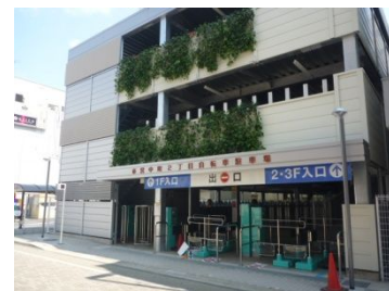
自転車専用駐車場
