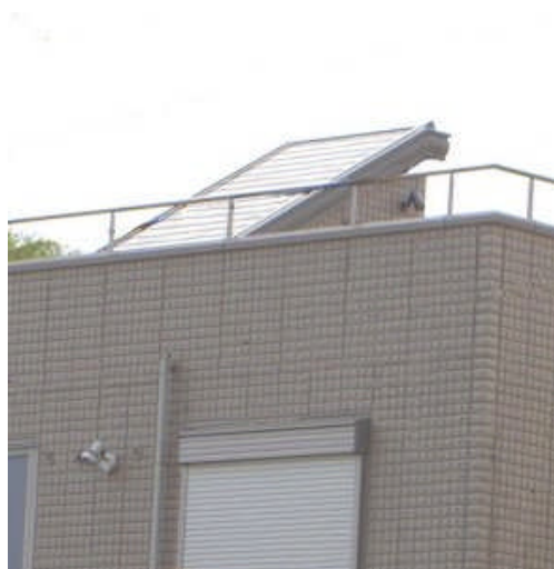
図. 太陽熱利用システム(強制循環型)
