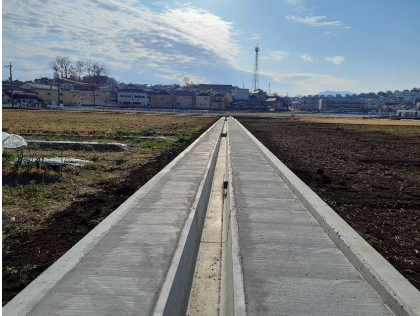
整備した農業用排水路
