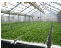
農業生産施設 （水耕栽培ハウス）
