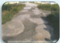
農道の窪みの補修
