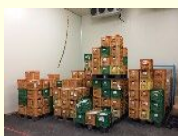
小規模貯蔵施設
