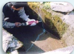
水路のひび割れ補修
