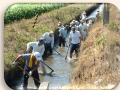
水路の泥上げ
