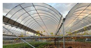
簡易雨よけ設備の設置
