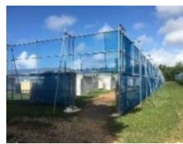
防風ネットの設置
