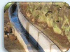
コンクリート水路の更新
