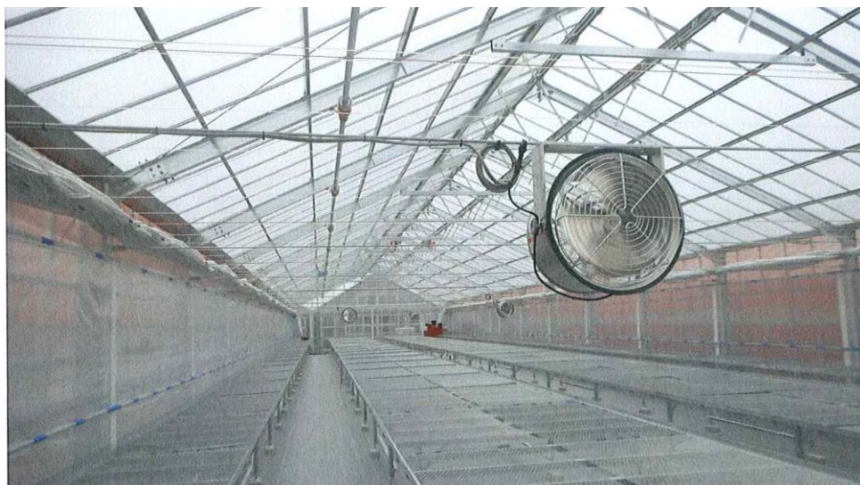
市内で整備された低コスト耐候性ハウス
