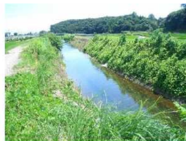
荻野川（広町公園付近）
