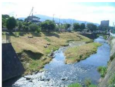
恩曾川（地藏橋付近）
