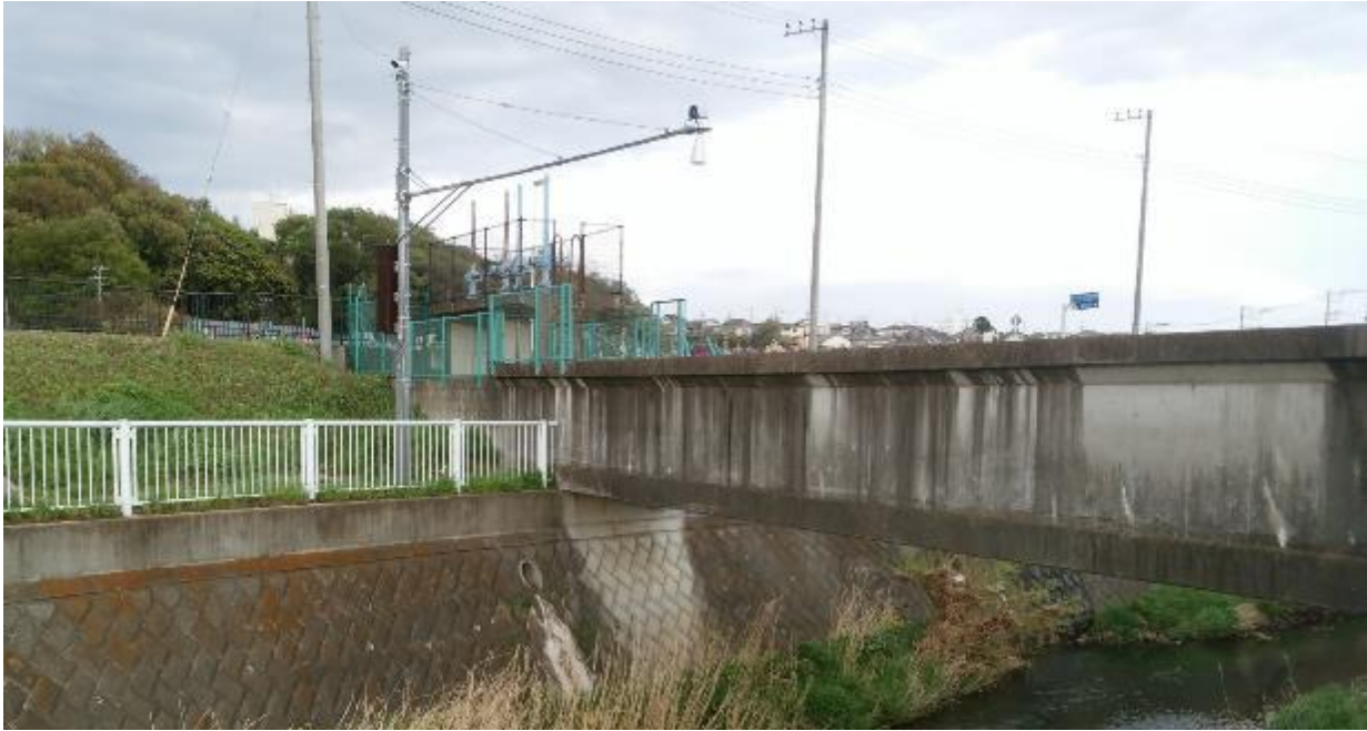
写真 3-1 温水橋上流付近に設置された水位観測施設・監視カメラ
