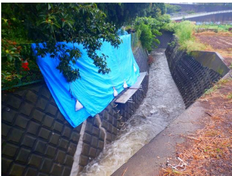
写真 3-5 ビニールシートによる護岸が破損した箇所の応急対応措置例
