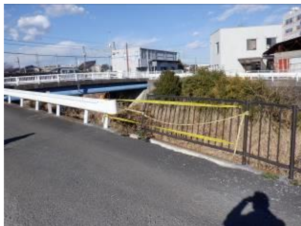
写真 3-4 巡視によって発見した転落防止策の破損状況 (応急的に立入禁止テープ対応)
