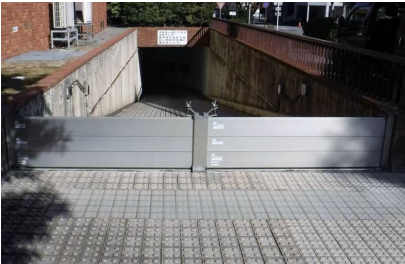
着脱式止水板
