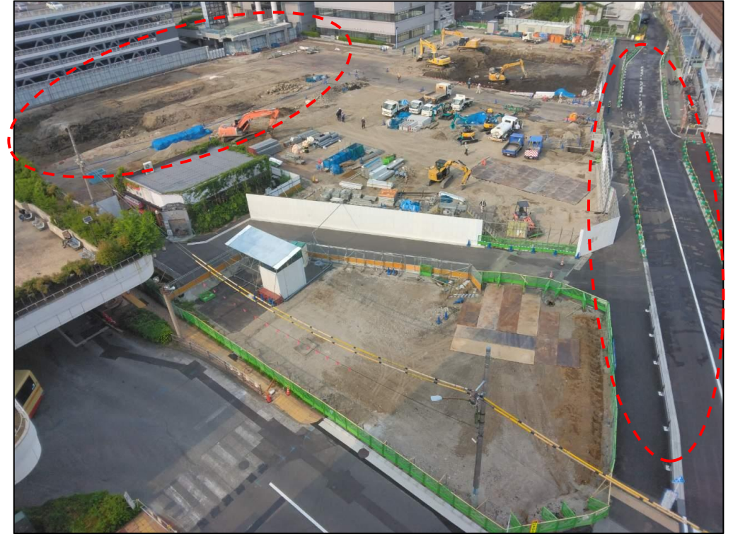
現在(本体建設工事着工前)【令和6年6月】
