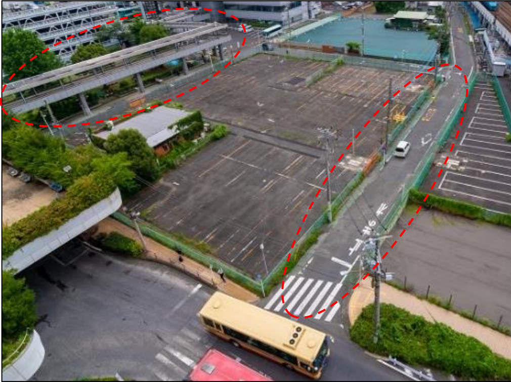
準備工事着工時【令和5年7月】
