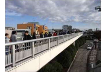
北口ペDESTリアンデッキの状況
