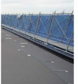
図表6 足場せり上げ状況
