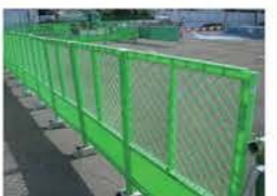
図表7 ガードフェンス設置例
