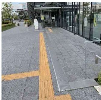
誘導ブロック設置
